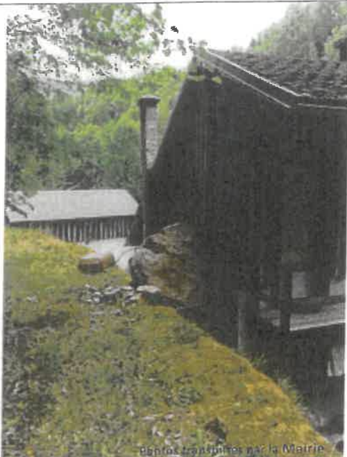
Bloc de 0.5 m 3 stoppé en façade amont de l'habitation
