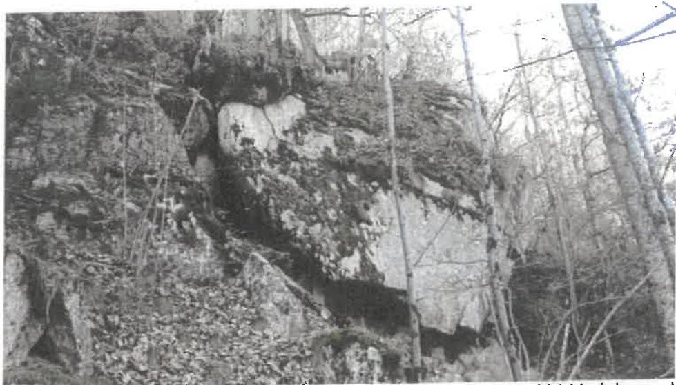
Vue d'une instabilité très volumineuse (de l'ordre de 100m 3 ) mis en évidence en périphérie de la zone de l'éboulement d'août 2017
